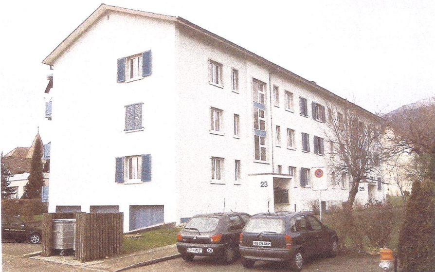
Ansicht von Osten
